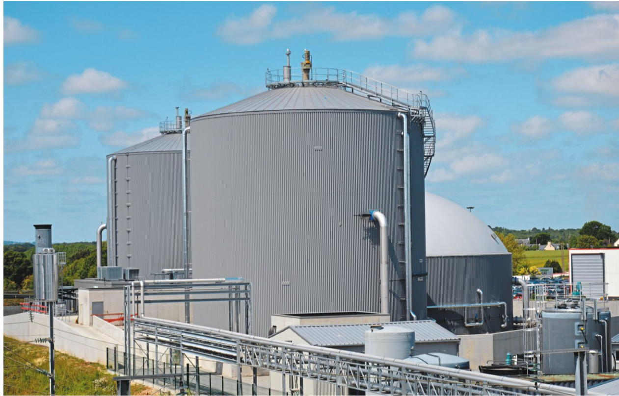
Angeschlossen: Die Biogasanlage in Lamballe kann 5000 Wohnungen à 100 qm mit Gas versorgen.
